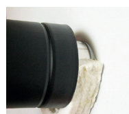
Isolera noggrant runt kopplingsstycket.
