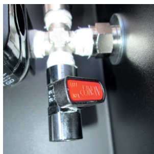
Säkerhetsventil i stängt läge
