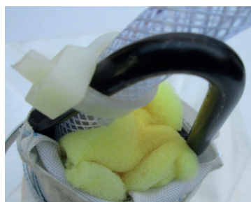
Steg 14. Fyll öppningen med skumgummi (detta för att tätningssmassan ej skall komma ner i påsarna)
