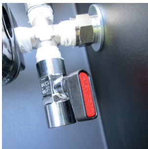
Säkerhetsventil i öppet läge
