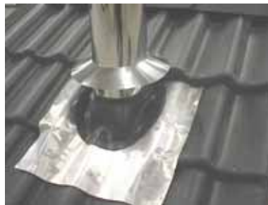
Tak overbeslag med gummistuss
